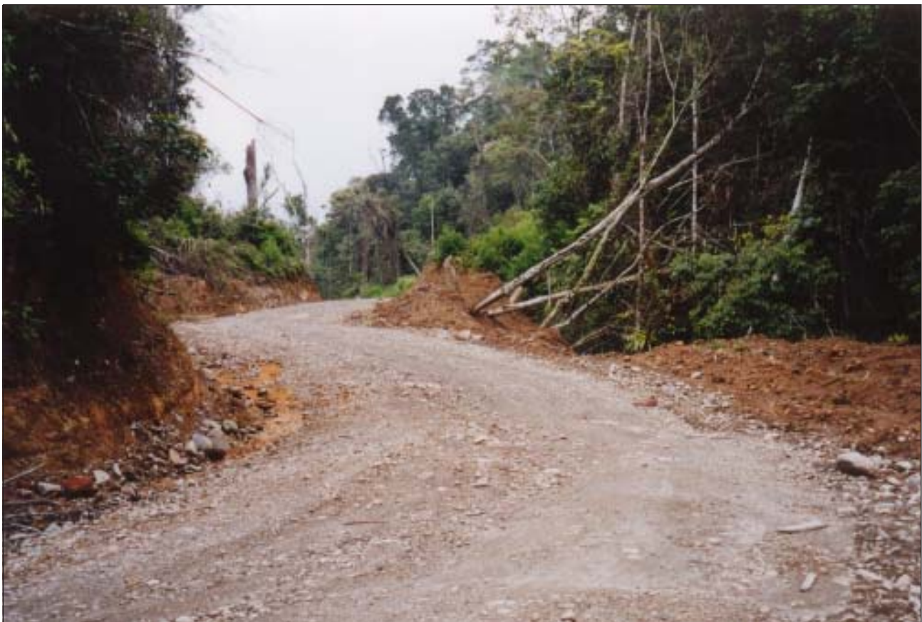
Pembangunan Jalan LADIA GALASKA
